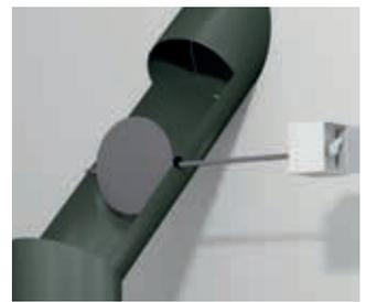
**TIPP** CB Luftklappengriffe mit verstärkter Feder z. B. zur Arretierung der Drosselklappen im Rauchgassammler.
